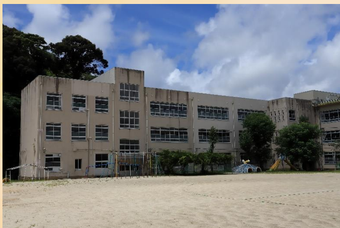
解体予定の西校舎
